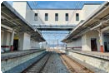
エレベーター (新桐生駅)
